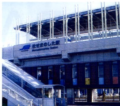
仙台空港鉄道杜せきのした駅
